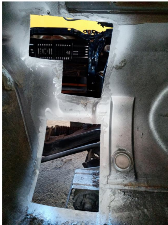
Figura 25- Remoção da chapa Oxidada
